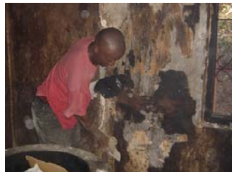
Peter Patrik i full aktion med att skrapa väggarna före målningen.
